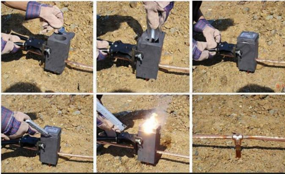
شکل ۳-۴- تجهیزات مورد استفاده برای انجام جوش آگزوترمیک
